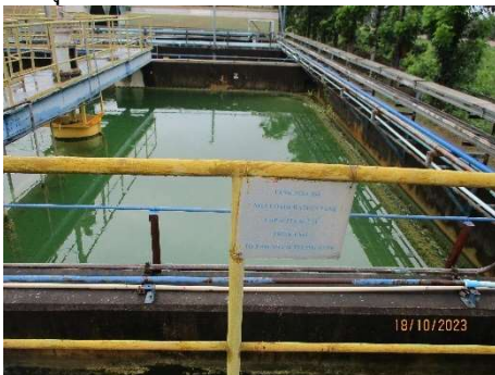
ภาพที่ 2-3 ระบบบำบัดน้ำเสีย แบบ Chemical-Physical Process
