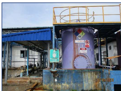
ภาพที่ 2-29 การสร้าง Bunding บริเวณพื้นที่ตั้งถังบรรจุสารเคมีที่เป็นของเหลว
